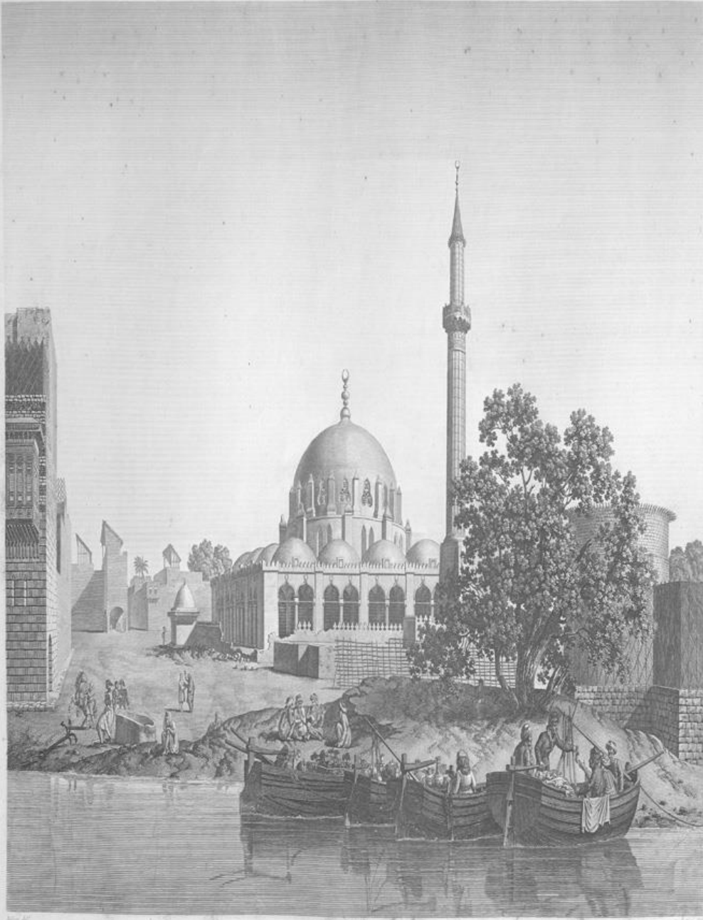
VUE DU PORT ET DE LA GRANDE MOSQUE DE BOULAQ.
