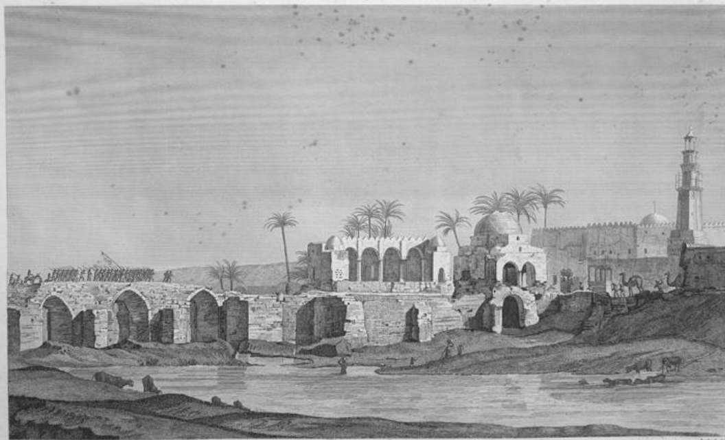
VUE DES ENVIRONS DE LA VILLE PENDANT L'INONDATION. VUE D'UN PONT SITUÉ A L'ENTRÉE DE LA VILLE.
