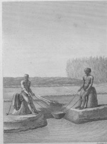
VUES ET DÉTAILS DE DEUX MACHINES À ARROSER, APPELÉES CHADOUF ET MENTAL.
