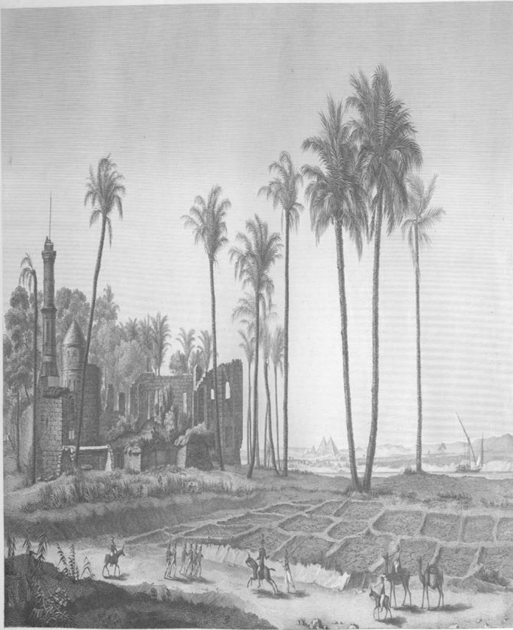
VUE D'UNE MOSQUÉE RUISÉE DANS L'ILE DE ROUDAH.
